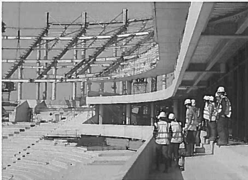
Stade Matmut Atlantique, Bordeaux (Gironde), mars 2014. L'étude de l'OCDE évalue à 20 000 les postes créés dans le BTP grâce à la modernisation des installations sportives. (Photo:QPR/4 Sud Ouest a/Fabien Cottreau)
